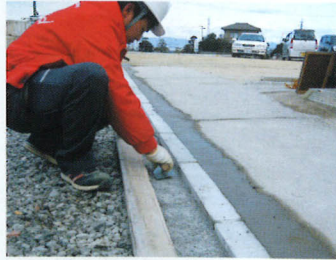
⑤：敷き均し
