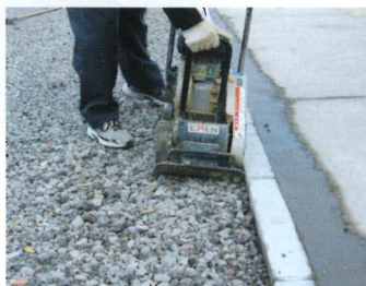
②：路盤転圧
