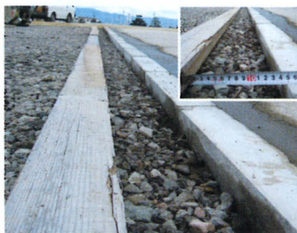
③：型枠設置
