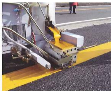
ベース材+リブ材施工中
