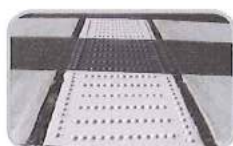
仕上がり全景
