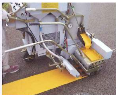
ベース材施工中
